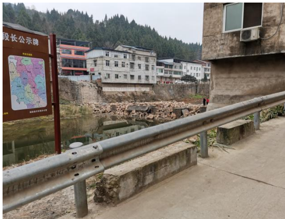
拦水坝 2# (已拆毁)
