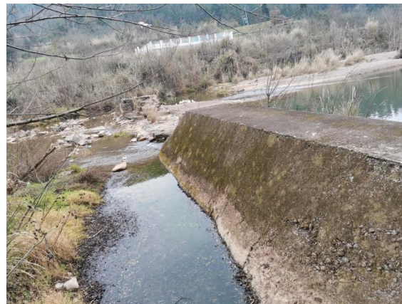
拦水坝 3# (已拆毁)
